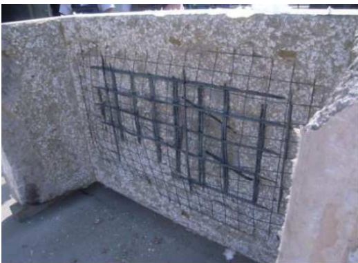
Abbildung 3: Probekörper aus Referenzbeton (ohne PP-Fasern) nach Großbrandversuch [3]
