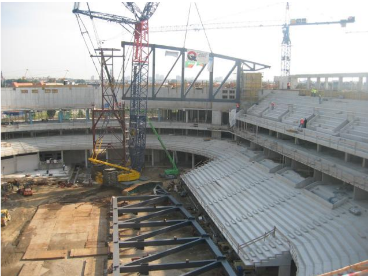
Abbildung 21: Montage des Hauptträgers Nord
