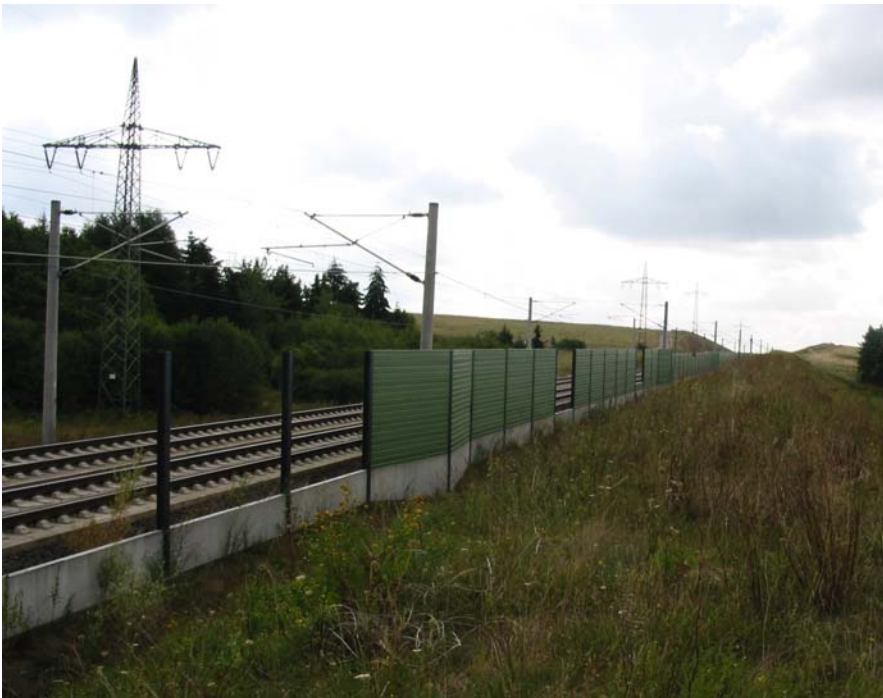
Abbildung 1: Lärmschutzwand mit zurückgebauten Paneelen an SFS Köln-Rhein/Main
