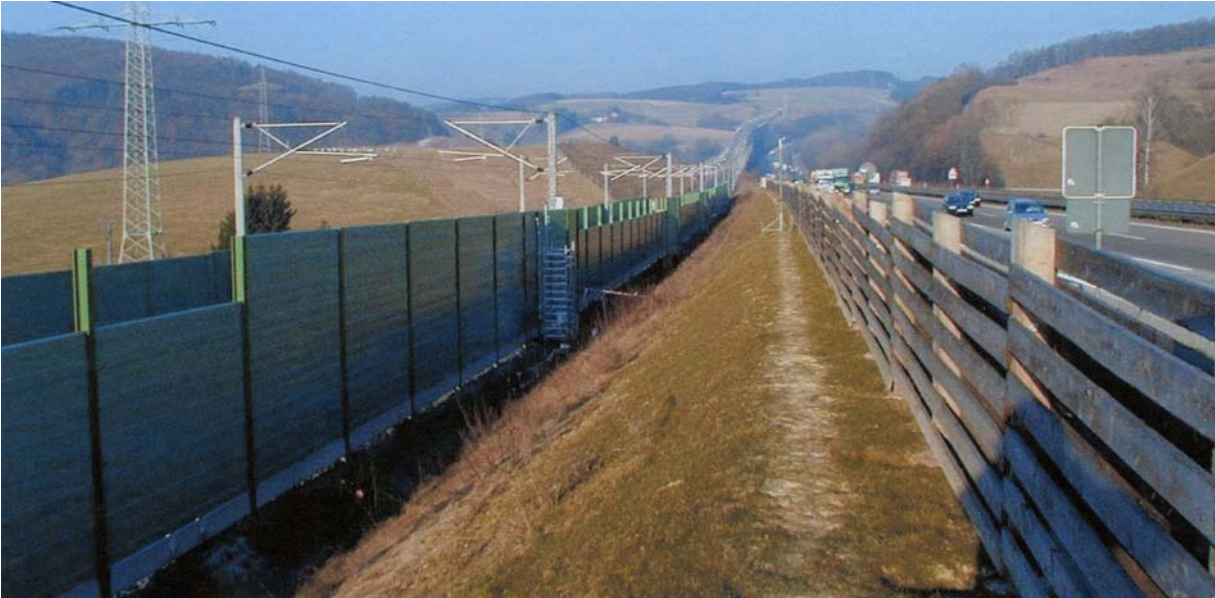
Bild 15: Schutzwand in Leichtbauweise ohne Längskopplung
