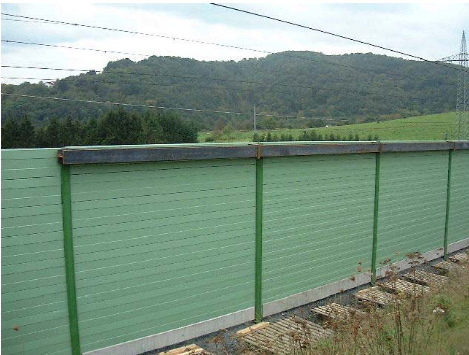
Bild 16: Schutzwand in Leichtbauweise mit Längskopplung
