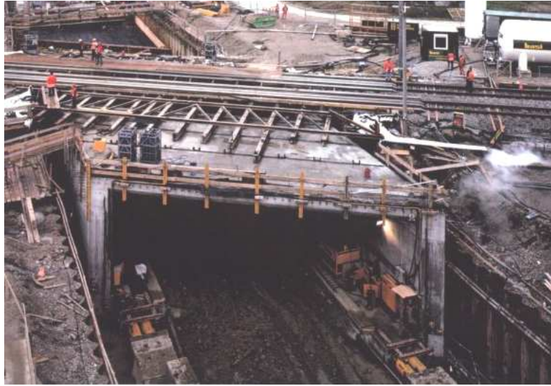
Bild 1: Beispiel einer schiefen Rahmenbrücke, EÜ über die K5311 (ABS/NBS Karlsruhe-Basel) [1]
