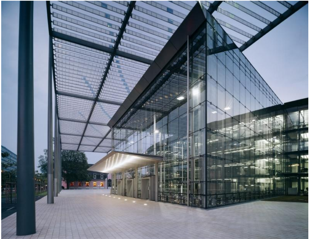
Abb. 12: Eingangslobby und Pergola
