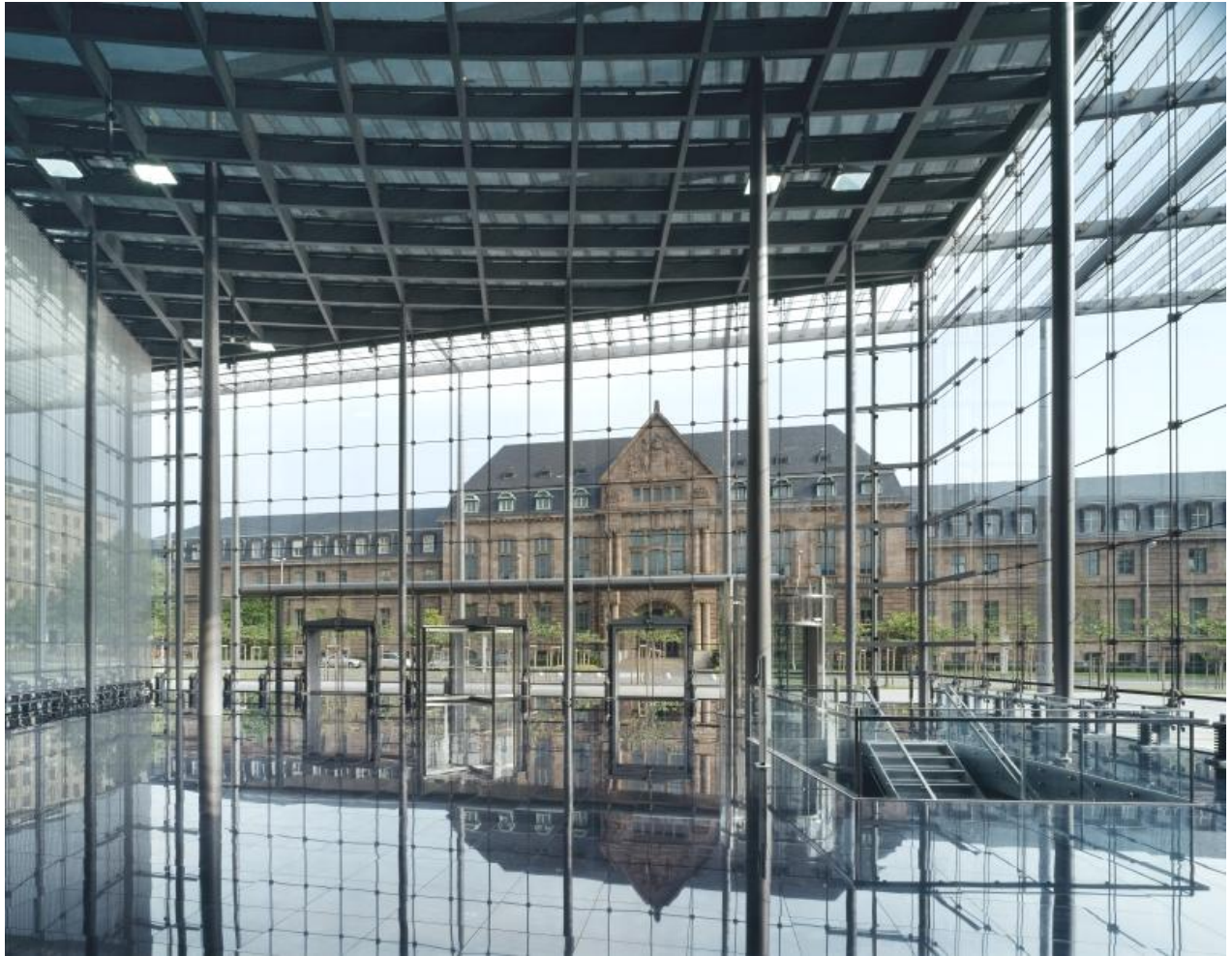
Abb. 4: Blick durch die Seilfassade der Eingangslobby auf die erste Konzernzentrale © Roland Halbe, Stuttgart
